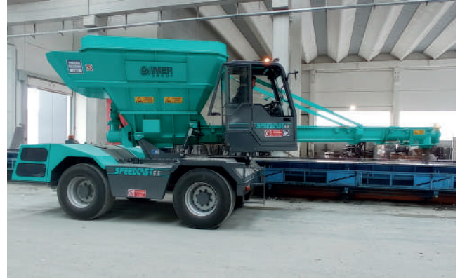
Coulée dans un coffrage horizontal avec du béton SCC
